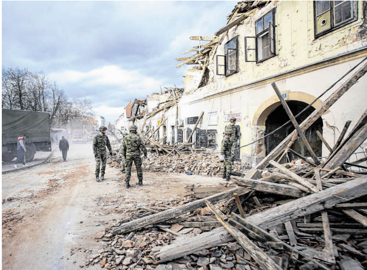
Die Bewohner von Petrinja stehen unter Schock: Zwei Drittel ihrer Stadt wurden vom Erdbeben zerstört. BILD: SN/AFP
