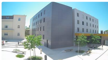
Pula: Gradilište Studentski dom
